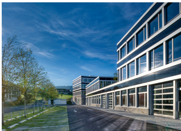
Hochwertige Glas-, Metallfassade
