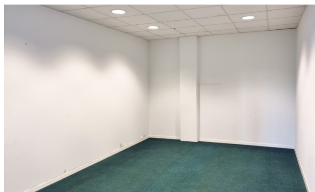
Archiv oder Serverraum
