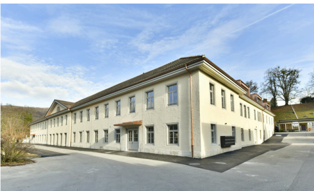
Hauseingang Hornimattstrasse 22a (Süd-/Westfassade)
