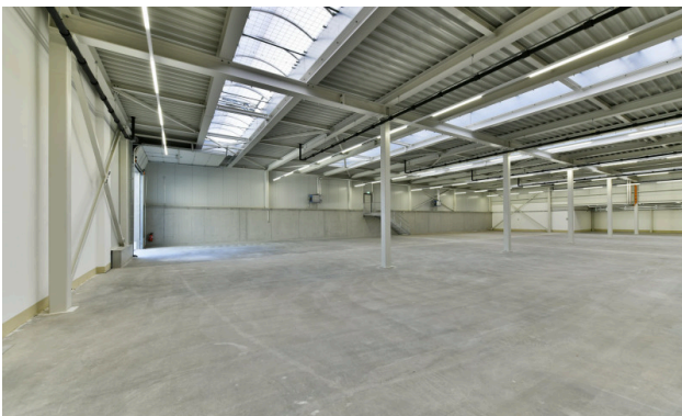
Lagerhalle ohne Mieterunterteilung
