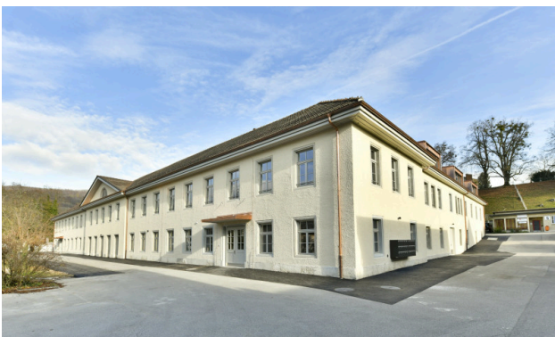
Hauseingang Hornimattstrasse 22a (Süd-/Westfassade)
