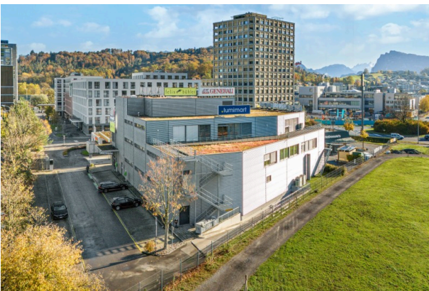
Aussenansicht / Parkplätze im Freien
