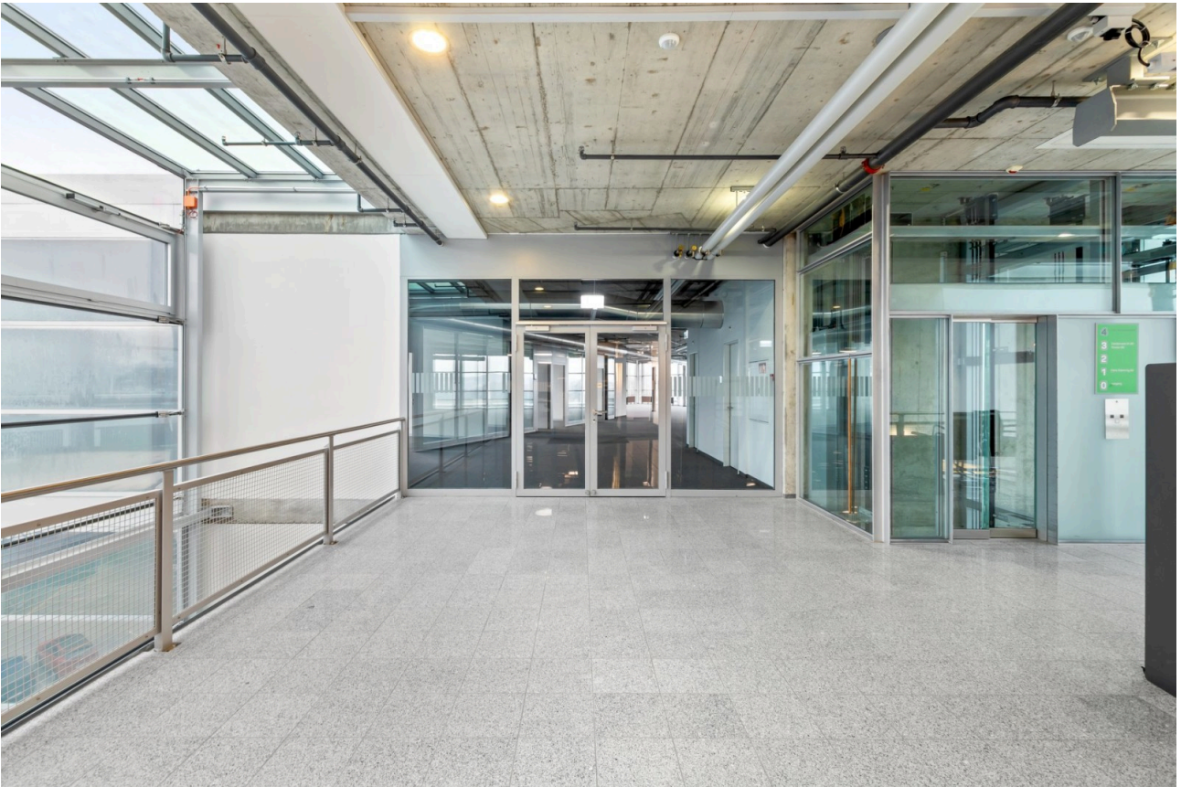
Treppenhaus mit Glaslift
