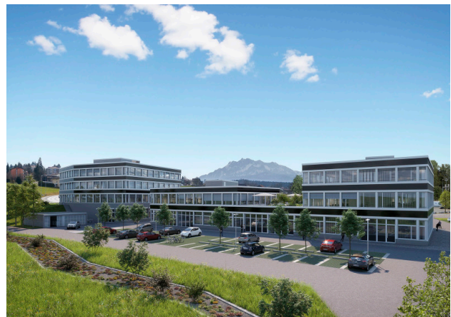
Rückseite der Gebäude 1, 3, 5 (von links)
