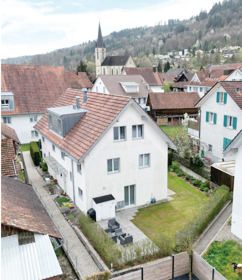
Sitzplatz | Süd-West Fassade
