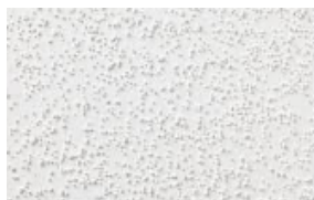
Spritzputz Decke (Styro; Weiss)
