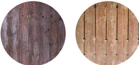
Haus A / Laube Bestehende Holzverschalung
