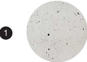
Terrasse / Laube Ortbeton
