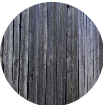
Scheune Bestehende Holzverschalung
