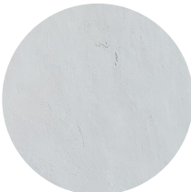
Haus A / Aussenwände Bestehende Putzfassade
