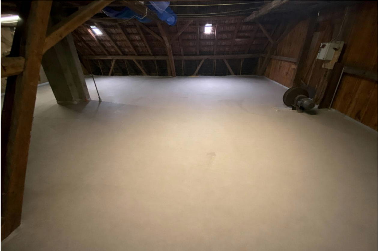
Estrich – Boden isoliert 2024, ca. 58.5 m 2 nutzbare Fläche
