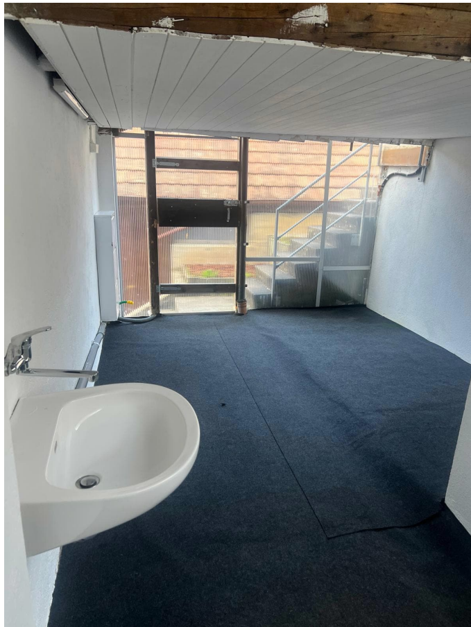
Sanitär-Vorinstallation für zukünftiges WC bereits eingebaut
