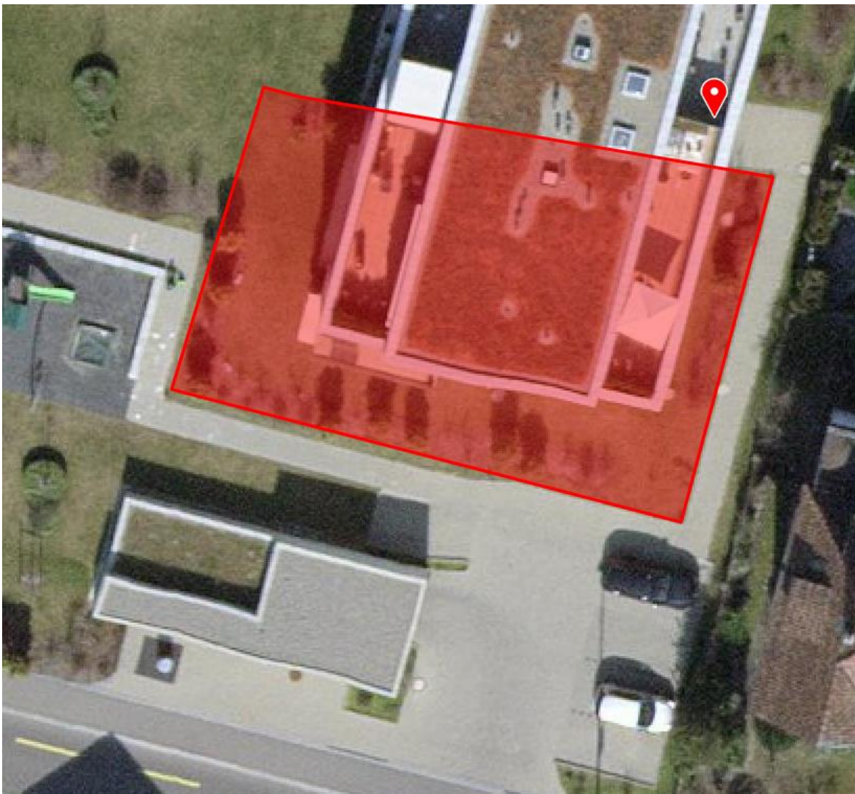
Bild: Wohnung mit Gartenanteil im Nutzungsrecht. Seit dem Bau gehört die Wohnung dem Ersteigentümer. Bei der Auswahl der Materialien und Geräte wurden ausschließlich hochwertige Produkte verwendet.
