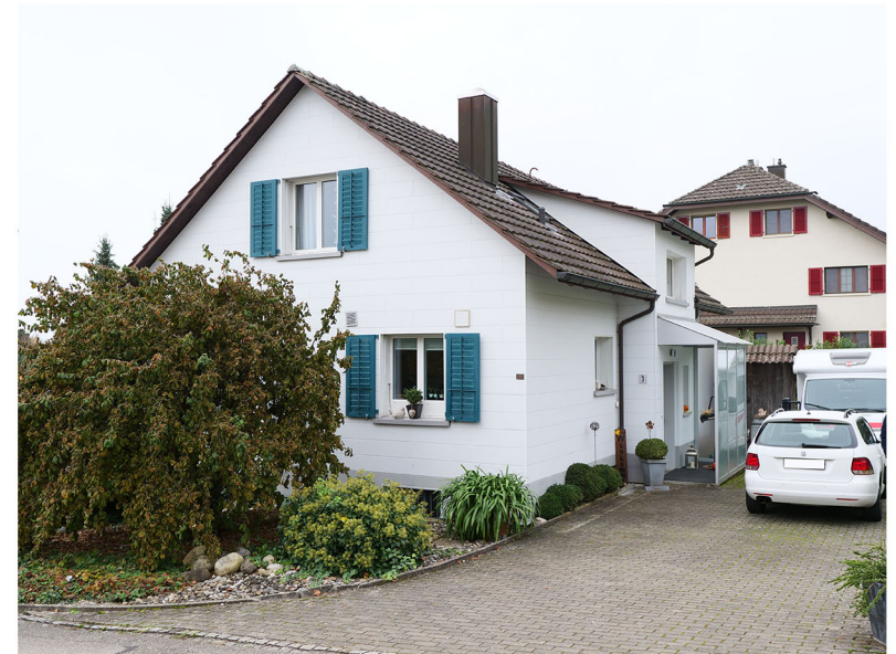
Eingangsseite mit Windfang
