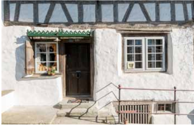
Hauseingang zum 5 1/2 Zimmer Hausteil
