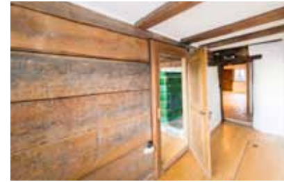
Nebenraum / kleines Büro
