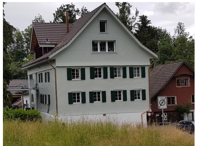
Gerberei Ansicht von Süden
