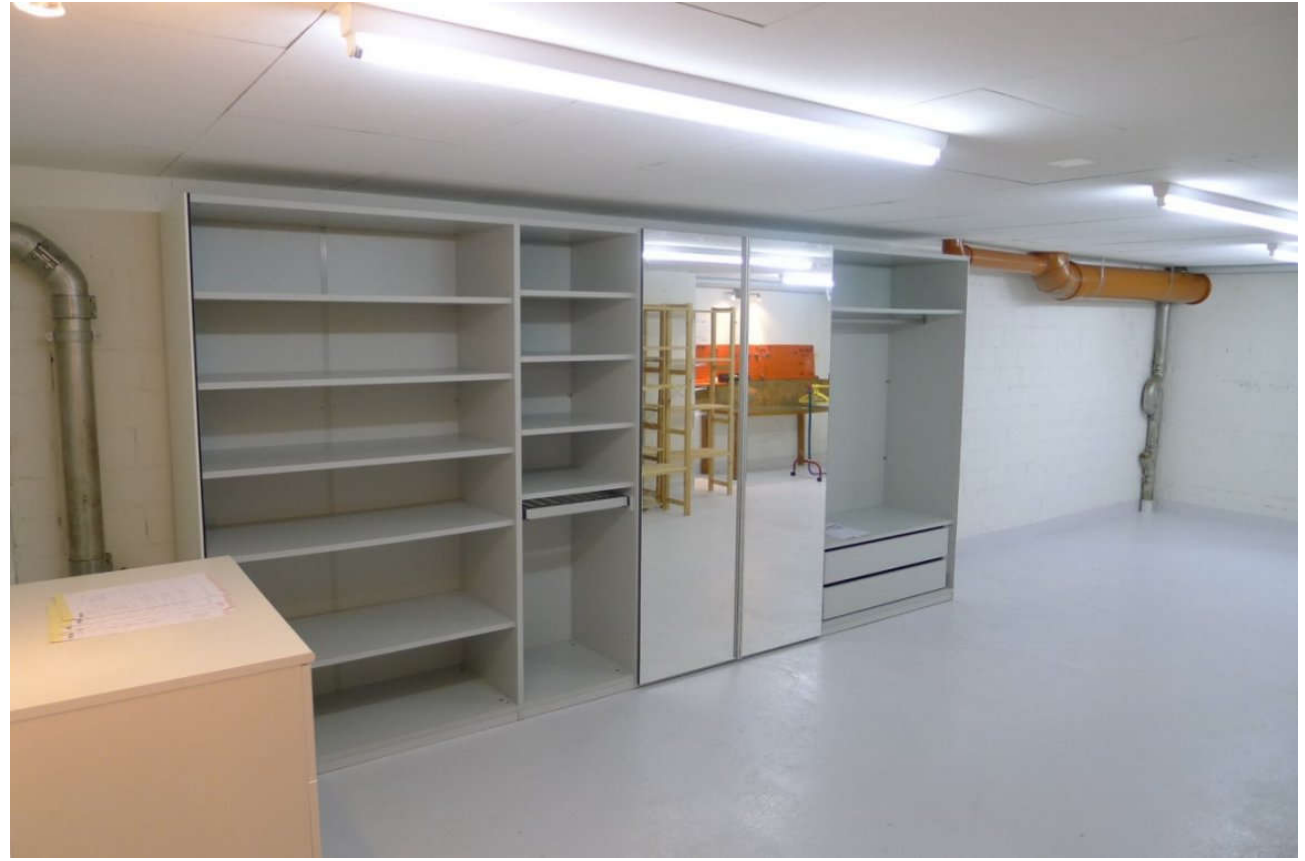
Unten: Keller (Bild vor Einbau Waschküche 2023)
