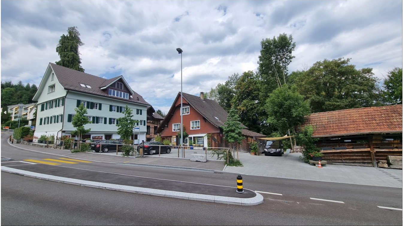
Gerbe mit 3er Ensemble links, Einfamilienhaus mit Studio Mitte, rechts Schopf mit Velounterstand. Vordergrund 8 Parkplätze und Bushaltestelle.
