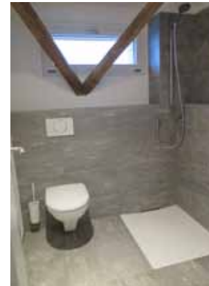
Dusche / WC OG2
