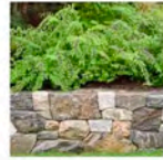
Mur en pierres et végétation
